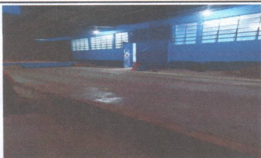
Foto 3: Se observa el nuevo patio de piso
